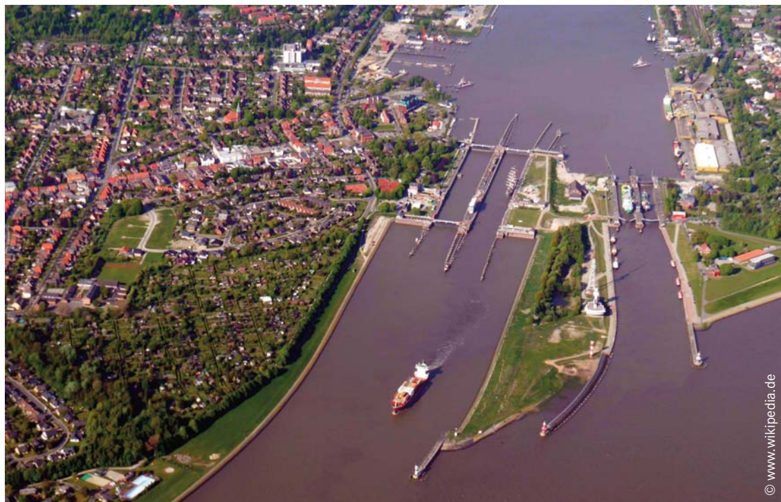
Die sanierungsbedürftigen Schleusen in Brunsbüttel
