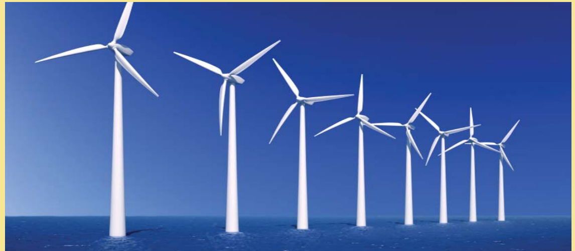
Mit HTS-Technologie sollen Offshore-Windmühlen deutlich kostengünstiger arbeiten
