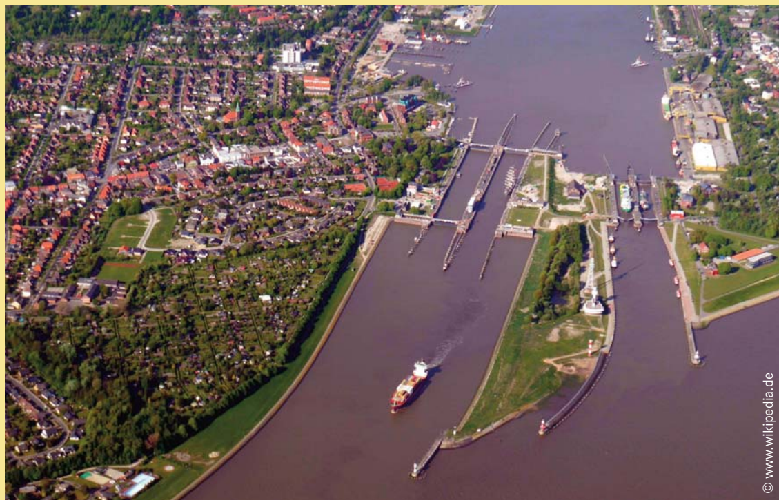
Die sanierungsbedürftigen Schleusen in Brunsbüttel
